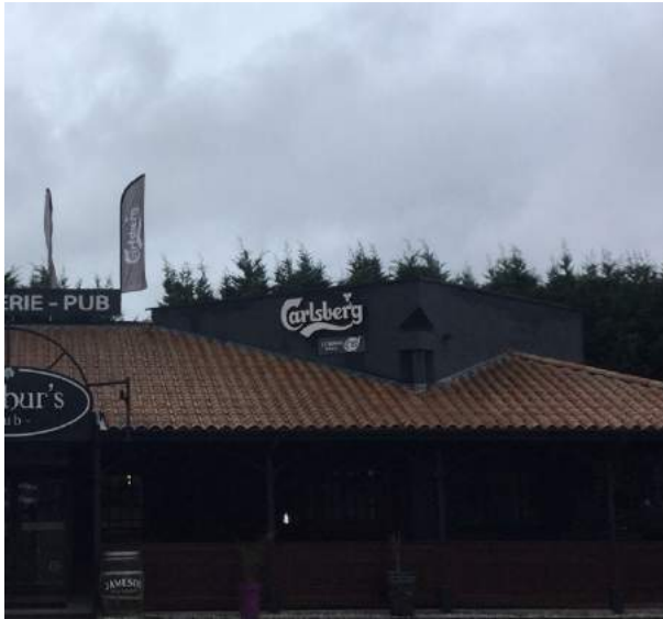
Enseigne sur toiture conforme, Lanton, Octobre 2019
