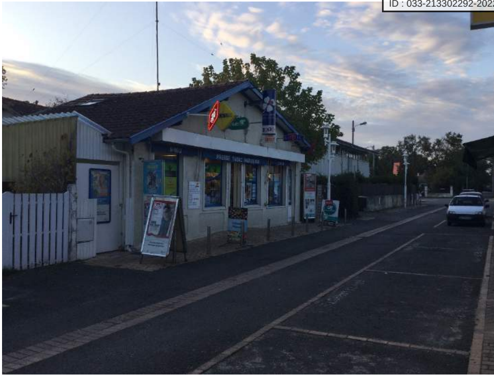
Enseignes perpendiculaires (conformes) au mur en nombre important, Lanton, Octobre 2019
