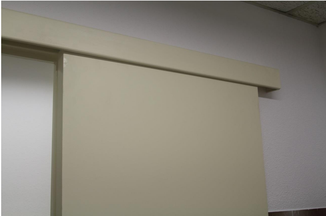
Système coulissant pour la porte du sanitaire adapté
