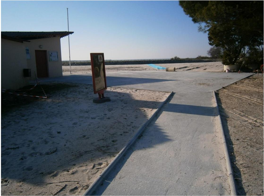
*Réaménagement de l'ensemble de la zone d'accès au poste M.N.S. en béton balayé*
