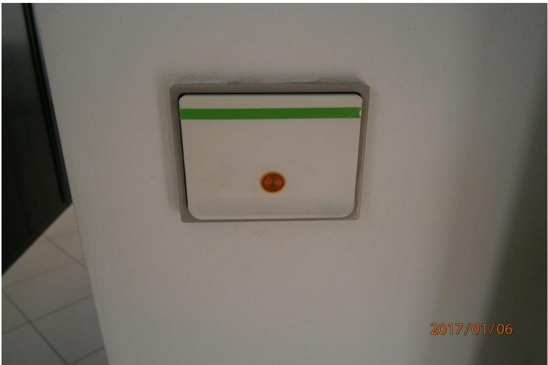
*Interrupteur existant avec pose d'un contraste visuel*
