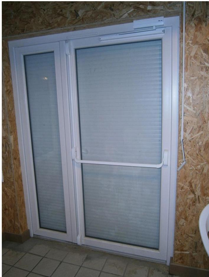
*Remplacement de la porte par une nouvelle porte disposant d'un ventail de 90cm*
