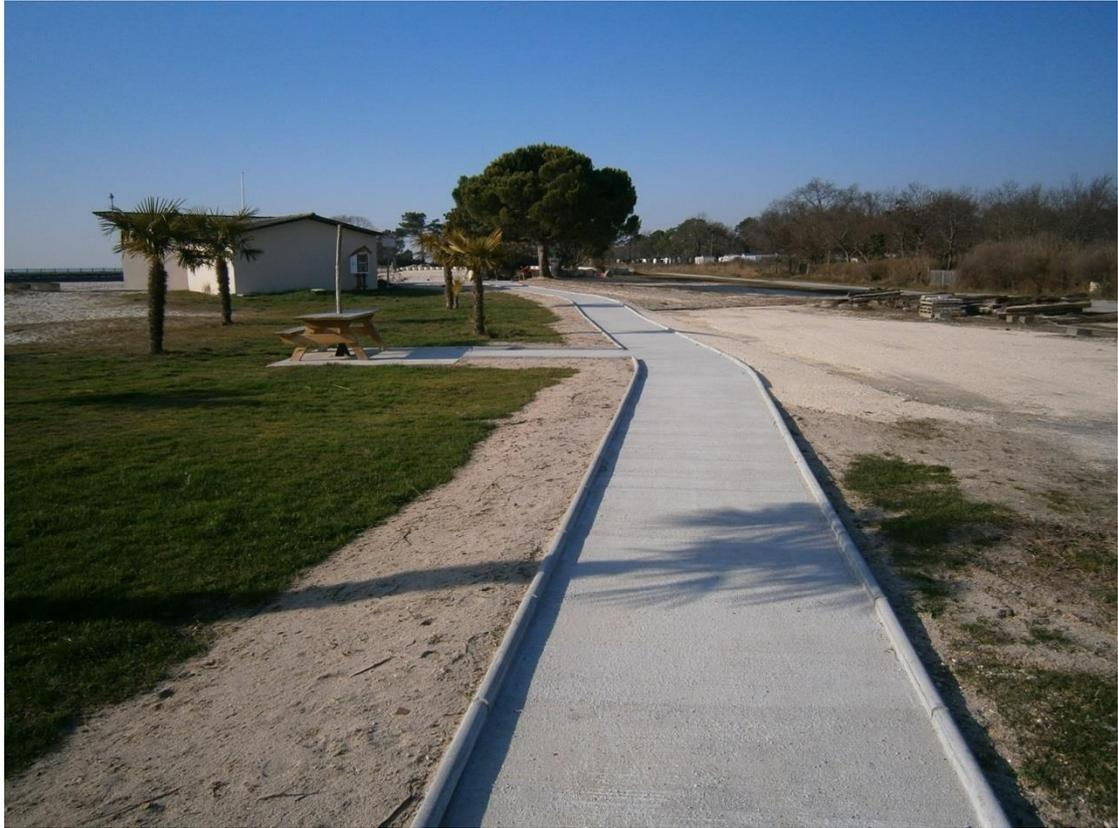
*Création d'une rampe PMR de 1,40m avec mise en place chasse roue et palier de repos tous les 10m*
