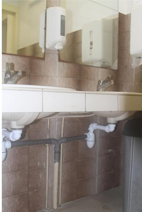
*Modification des siphons afin de permettre au fauteuil le passage sous le plan de travail*
