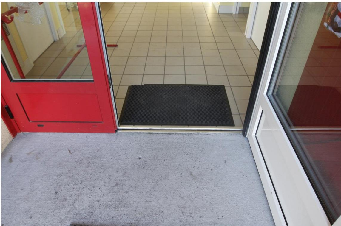
*Modification du ressaut inférieur à 2cm au niveau de la porte d'entrée principale*
