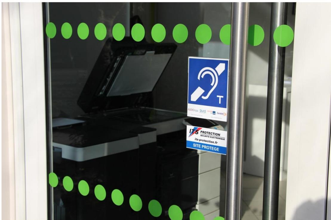
*Installation de bandes adhésives à 1,10m et 1,60m du sol, de chaque côté du vitrage et pose du pictogramme d'une boucle magnétique portable*
