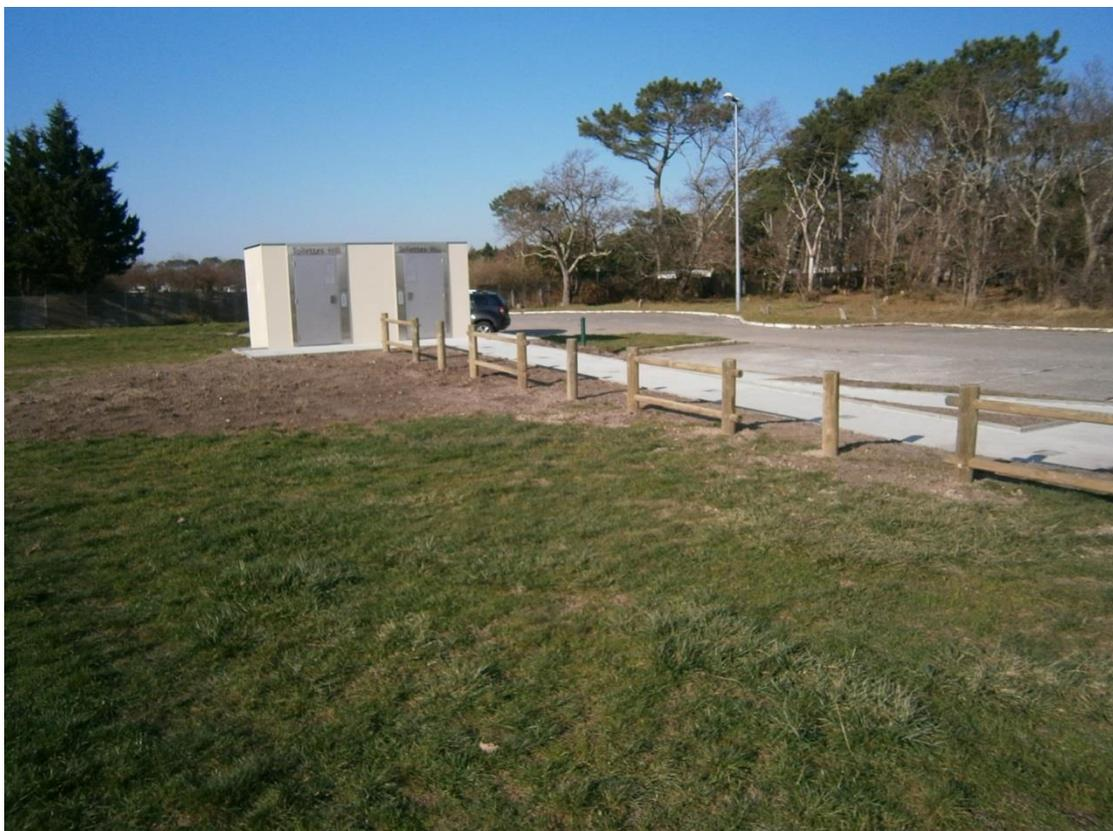
*Mise en place d'une rampe permettant l'accès d'une largeur de 1,40cm avec paliers et chasse-roue adaptés*
