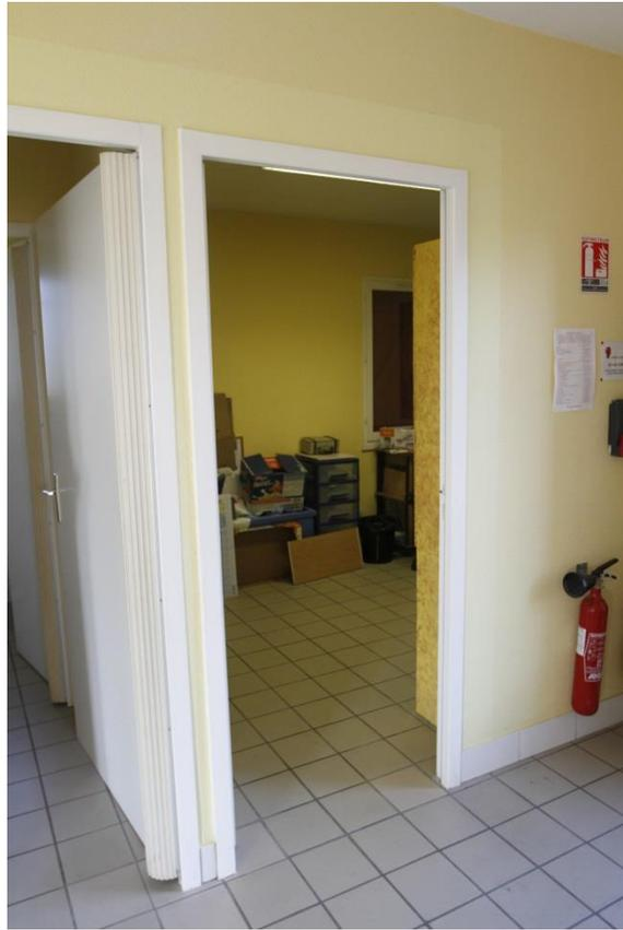
*Reconfiguration de la largeur de passage à 90cm pour le « bureau » et pose d'un système anti-pincement
