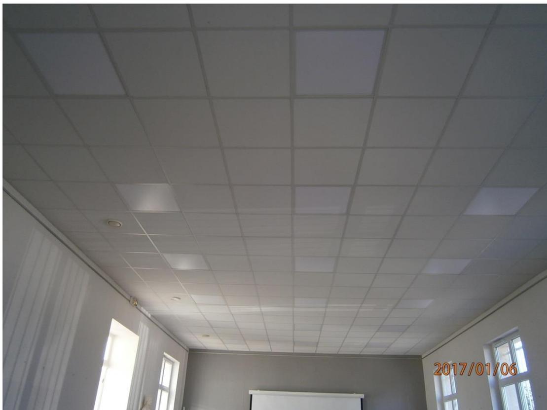
*Remplacement de l'ensemble du plafond de la salle du conseil avec remplacement des éclairages à LEDS*
