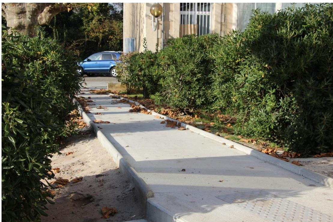
*Rampe 1,50m de largeur avec chasse roue*
