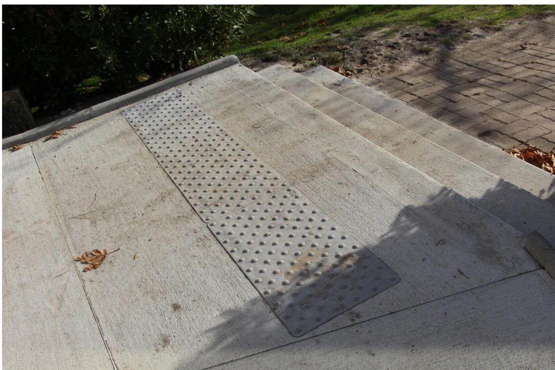
*Mise en place de dalles podotactiles à l'abord des marches*
