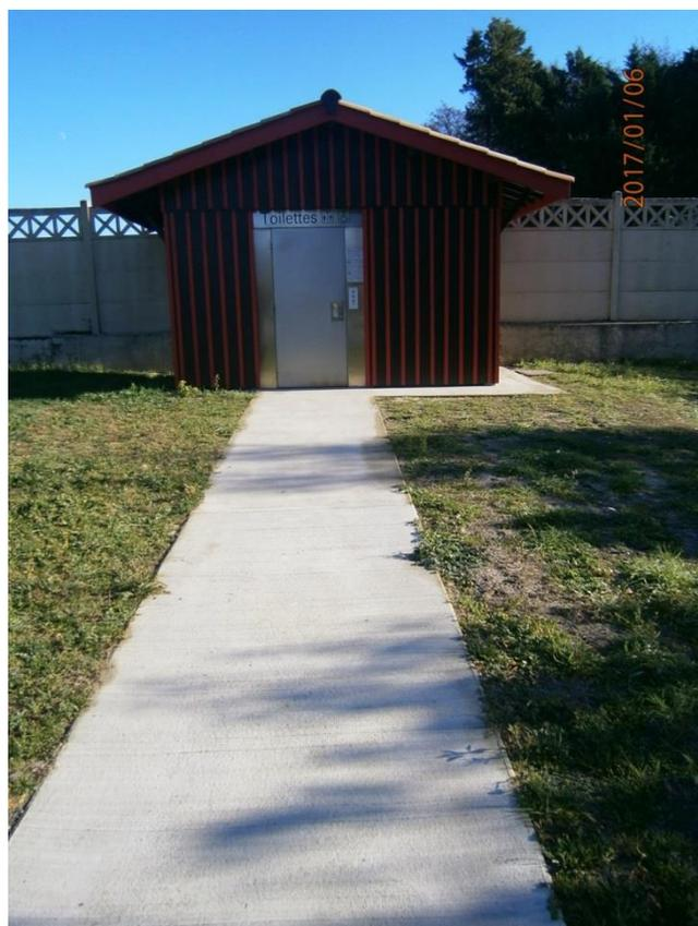
*Rampe ne nécessitant pas de chasse-roue et sans palier car inférieure à 10m de longueur*
