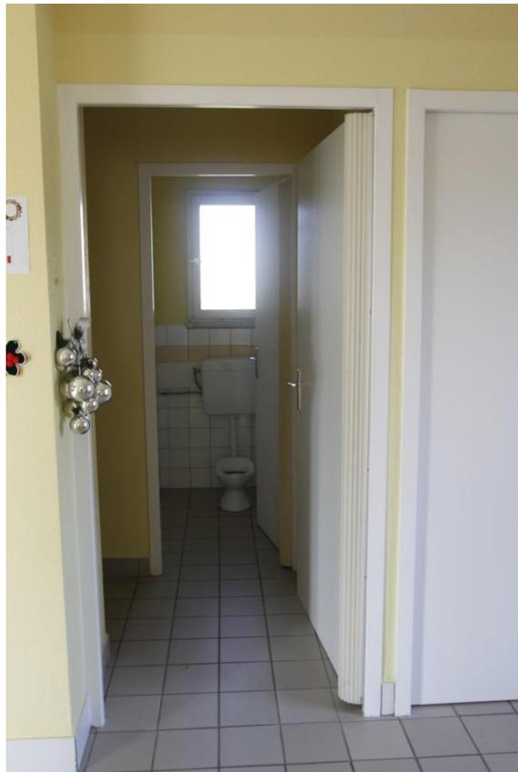
*Reconfiguration de la largeur de passage à 90cm pour les toilettes «garçons» et pose de système anti-pincement*
