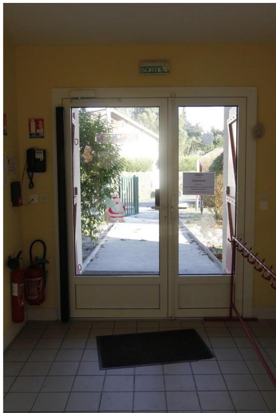
*Remplacement de la porte d'entrée avec largeur de passage à 90cm conforme*
