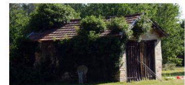
Hangar en briques et ouvertures bois
