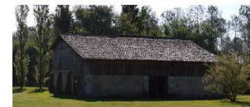
Hangar à bases murales en briques enduites
